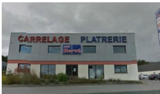
Entreprise de Carrelage et de Plâtrerie-Zone d'activité échangeur 27
