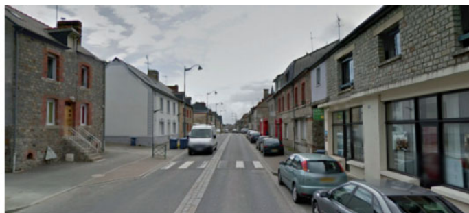
Front bâti mitoyen délimitant nettement l'espace public
