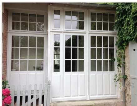
Menuiserie en bois à petits carreaux
