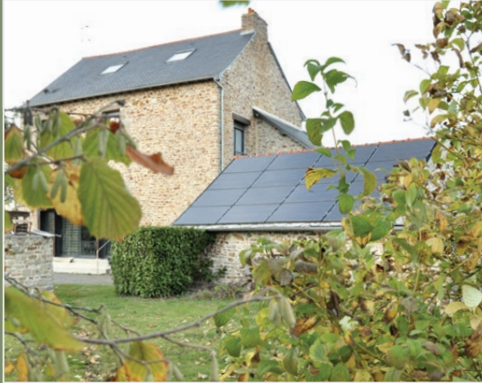
Exemple d'insertion de panneaux solaires sur une construction secondaire de plus faible hauteur
