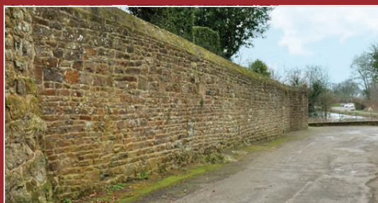
Mur de clôture
