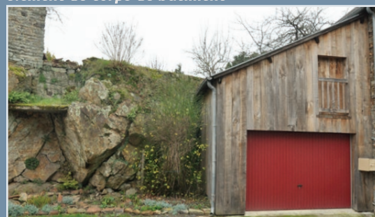
Porte de garage sur volume secondaire en extension
