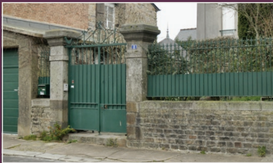
Exemple de mur bahut avec tôle brise vue
