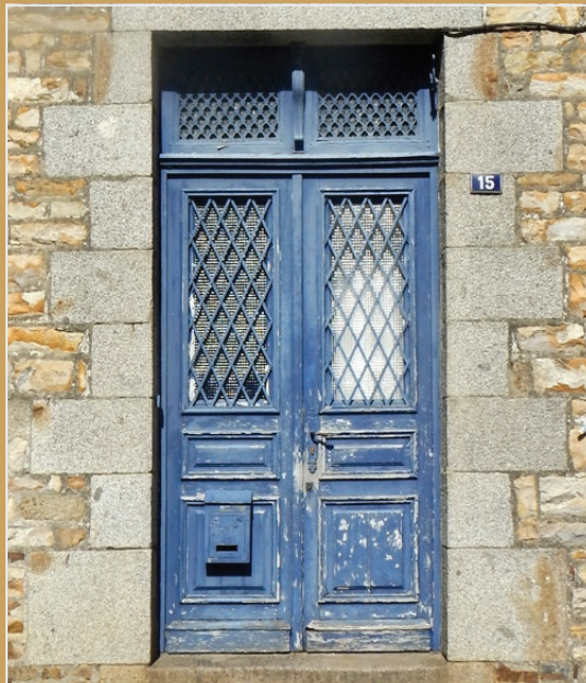
Porte à conserver et à restaurer
