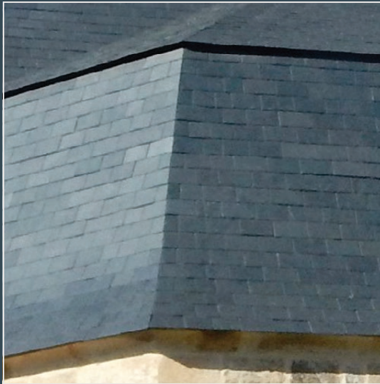
Arêtier en ardoises
