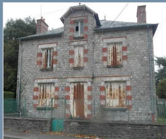
Composition symétrique d'une façade principale à restaurer
