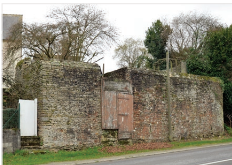
Mur de soutènement à barbacanes
