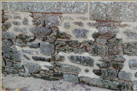
Échantillon de rejointoiement : témoin en place
