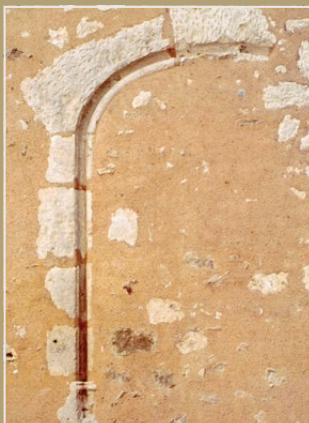
Enduit chaux à pierres devinées
