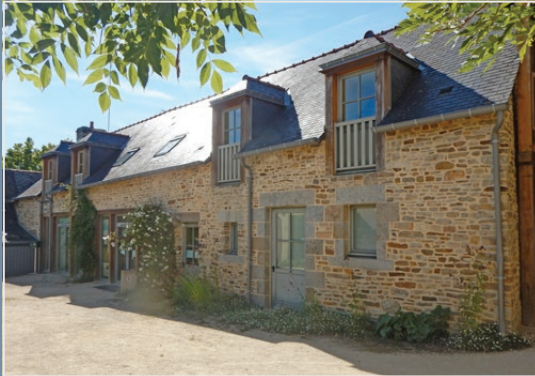
Façade composée et jeu de lucarnes passantes
