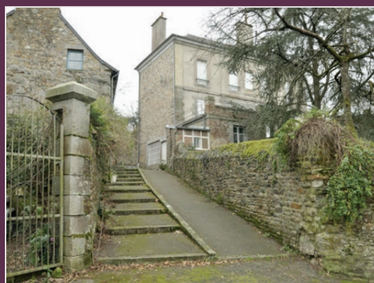
Exemple de mur plein en pierre et pilastre
