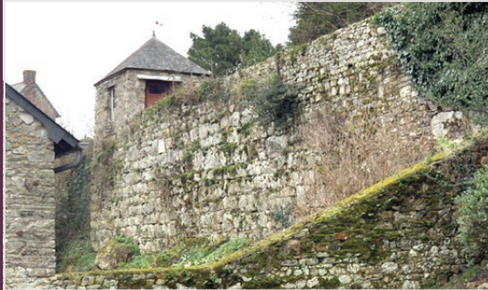
Mur de rempart
