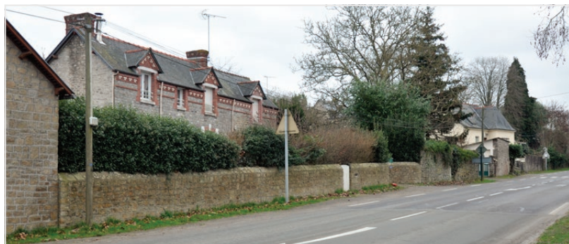
Murs de clôture structurant l'alignement
