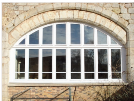
Menuiserie dans une ouverture cintrée
