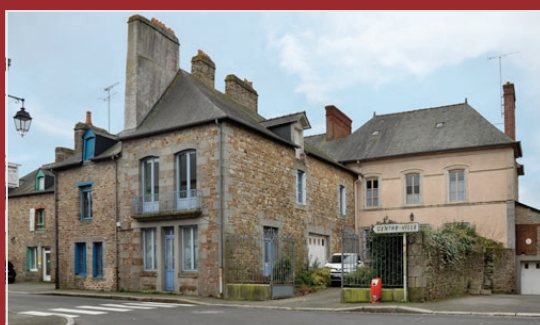
Immeuble bâti protégé dit « d'accompagnement »
