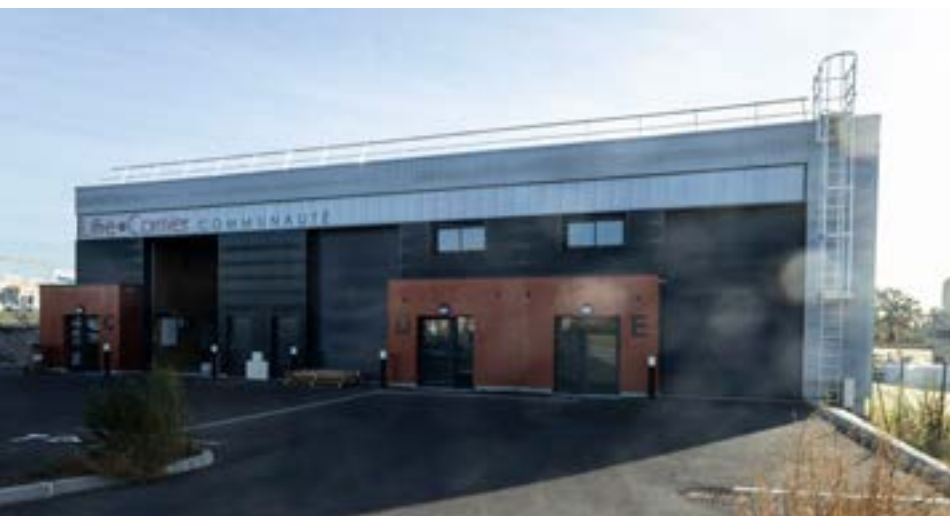
Ateliers relais de Saint-Aubin-du-Cormier
