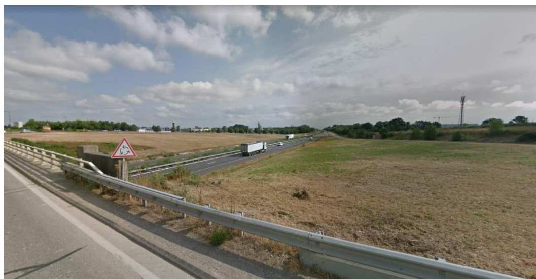
Figure 4 : vue sur la rupture de la continuité écologique n°2 liée à l'A84
