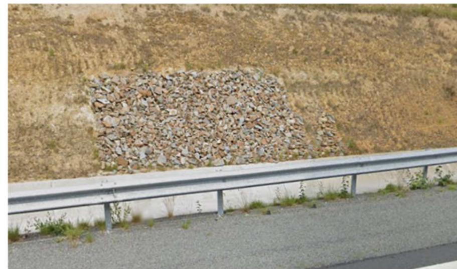
Figure 110 : Exemple d'empierrement ponctuel réalisé sur un talus routier
