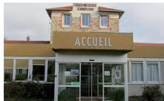
Centre Rey-Leroux - La Bouëxière
