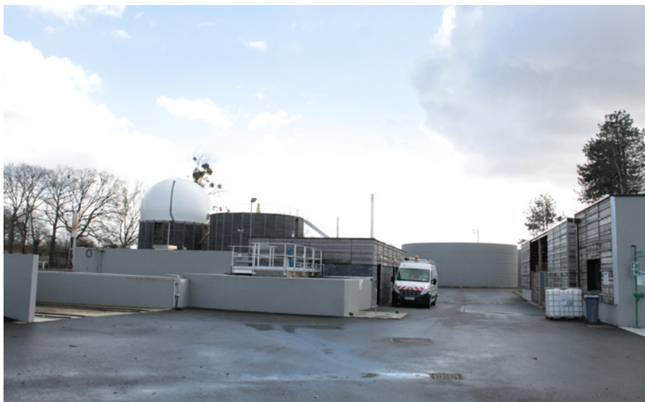
Station d'épuration à méthanisation de Liffré
