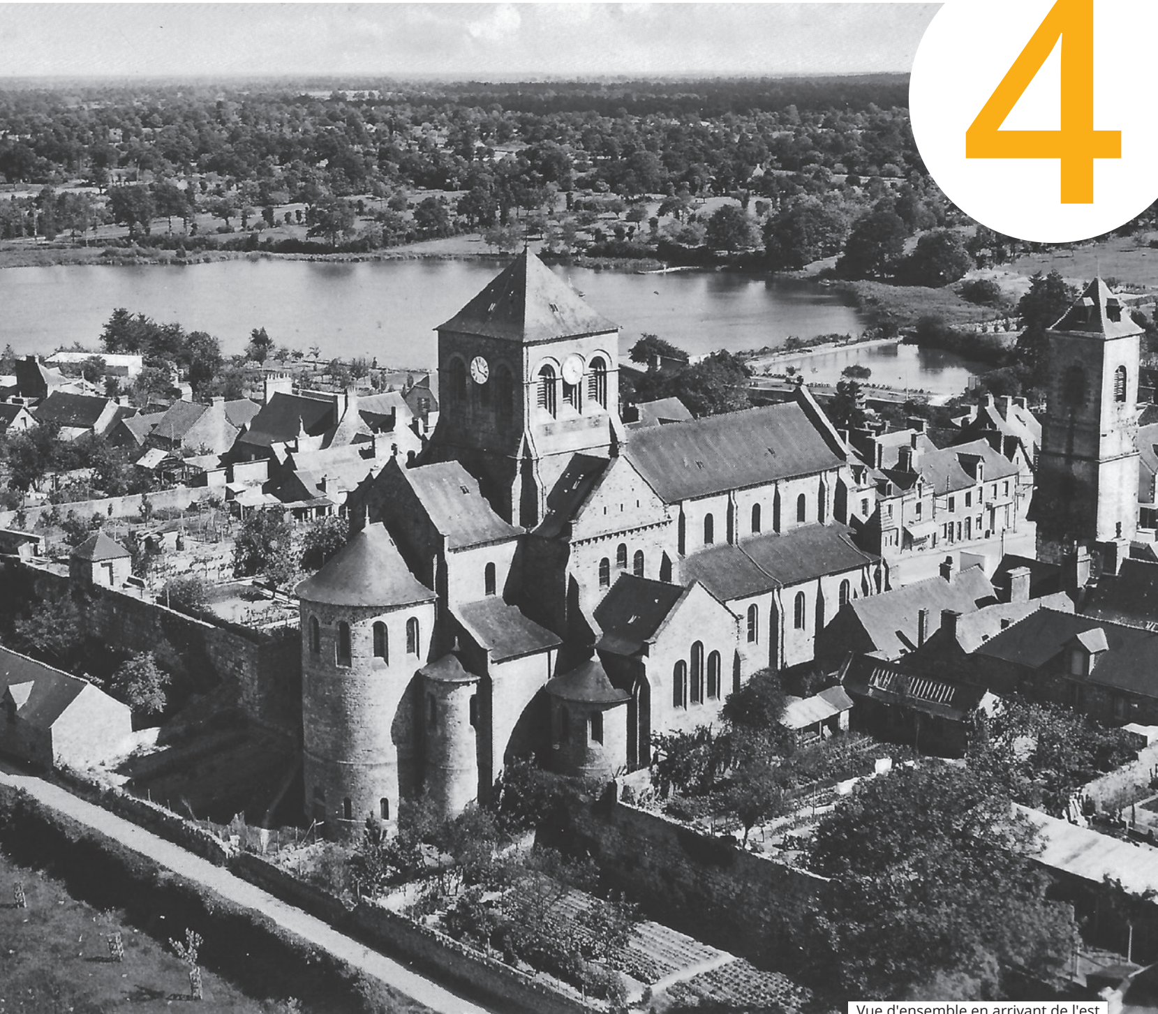
Vue d'ensemble en arrivant de l'est
